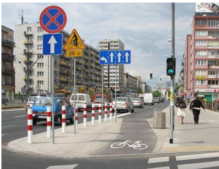
Przykład poprawnego włączenia ścieżki rowerowej do jezdni (Warszawa).
