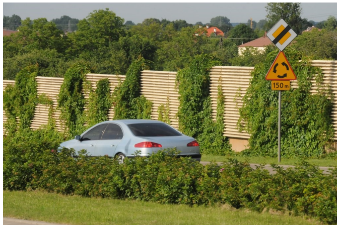
Rysunek 16-27 Dyfraktor zamontowany na krawędzi górnej ekranu akustycznego (źródło www.techbud.com.pl )
