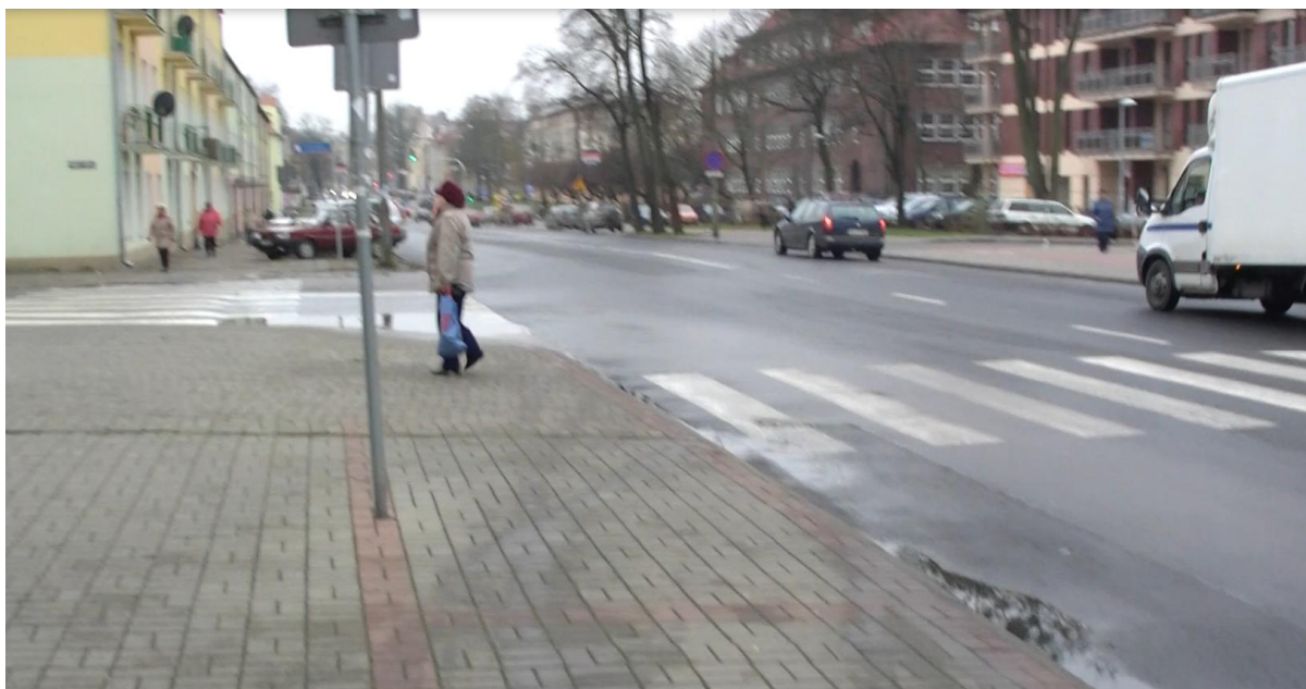
Zdj. 8. Skrzyżowanie z ulicą Rataja.
