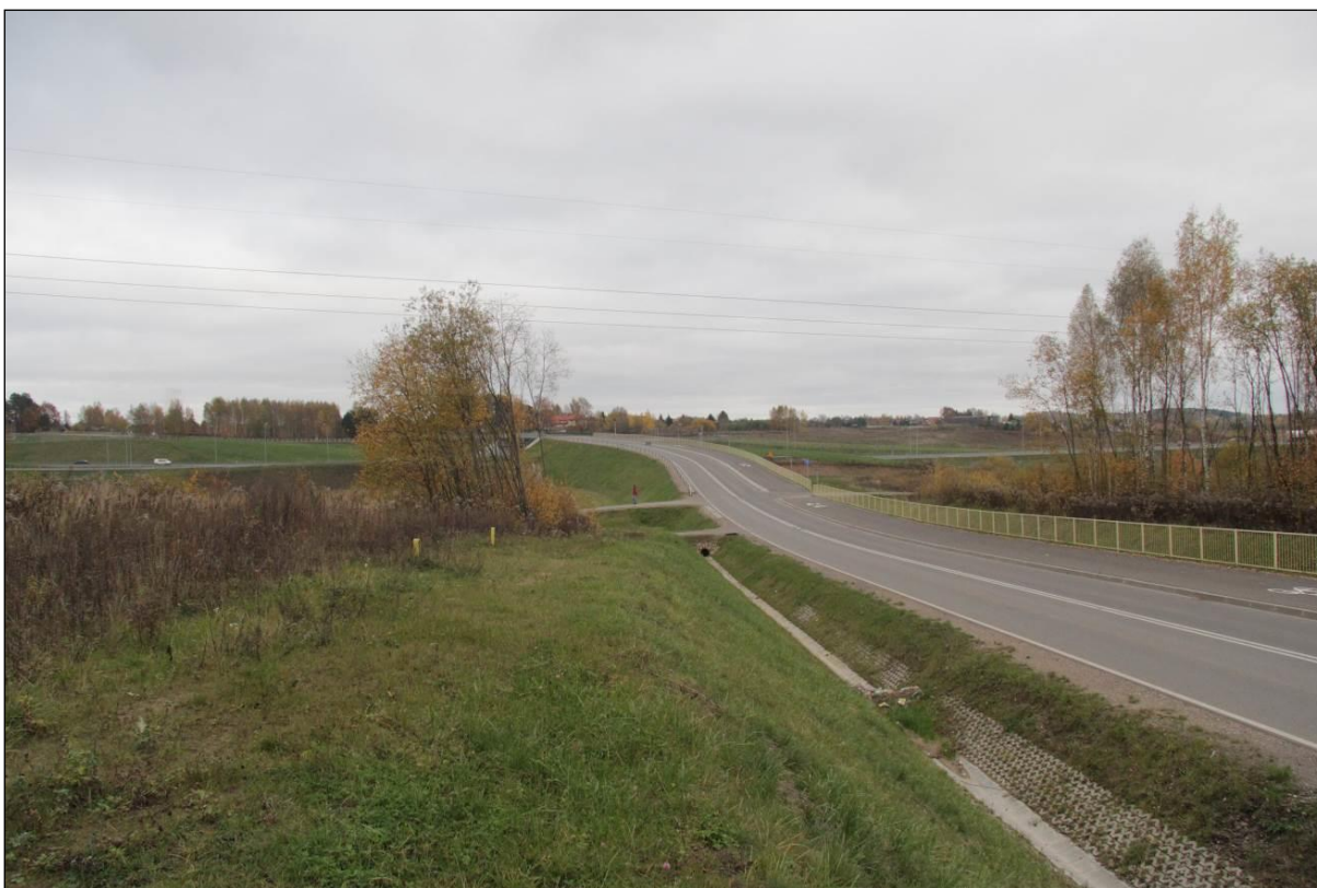
Fot. 3 Widok na drogę serwisową DK 16 i umocnioną skarpe (fot. własna, III.2020 r.)
