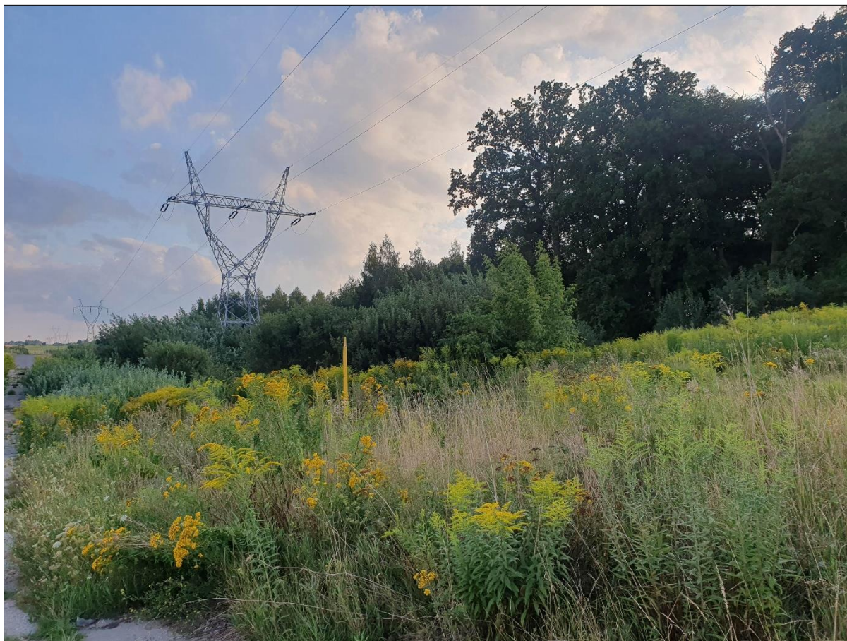
Fot. 4 Widok na pobliską napowietrzną linię elektroenergetyczną 220 kV (fot. własna; VIII.2023 r.)
