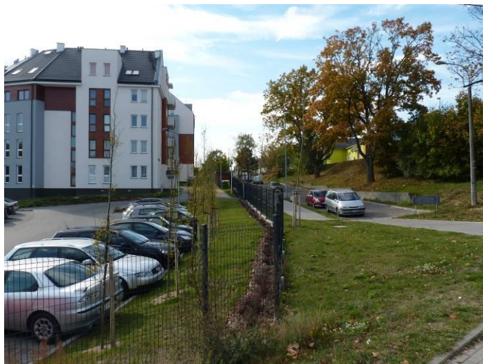
Zdjęcie. Zabudowa mieszkaniowa wielorodzinna zlokalizowana w części północnej obszaru opracowania. W oddali po prawej stronie pomiędzy drzewami widoczny budynek usługowy (z żółtą elewacją).
