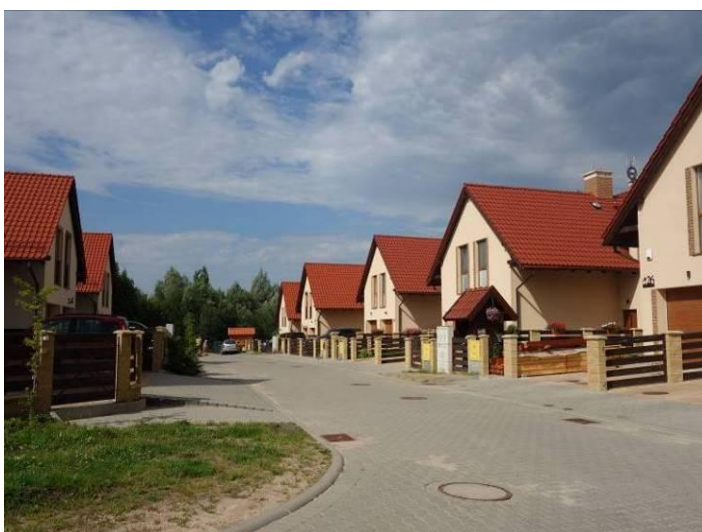
Zdjęcie. Zabudowa mieszkaniowa jednorodzinna szeregowa zlokalizowana w części południowej obszaru opracowania.
