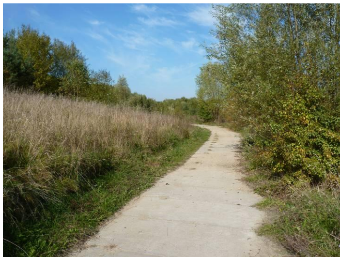
Zdjęcie. Droga utwardzona płytami betonowymi przebiegająca przez centralną część terenu opracowania (w kierunku północ-południe).
