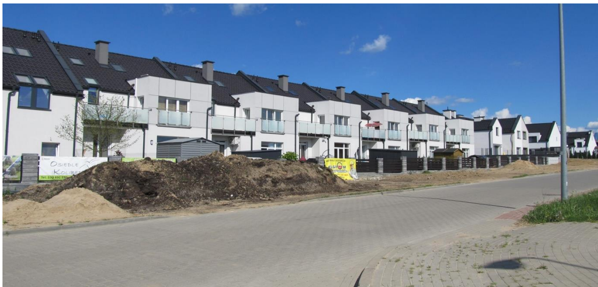
Zdjęcie 2. Zabudowa szeregową wzdłuż ul. Marcina Antonowicza
