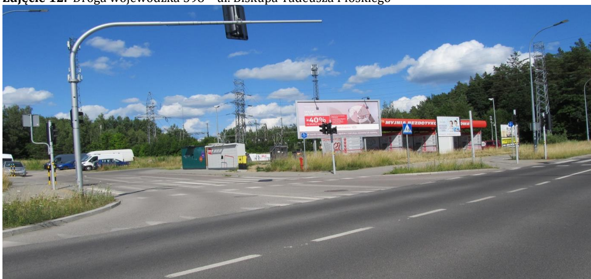
Zdjęcie 13. Sieć wysokiego napięcia przebiegająca w sąsiedztwie ul. Płoskiego
