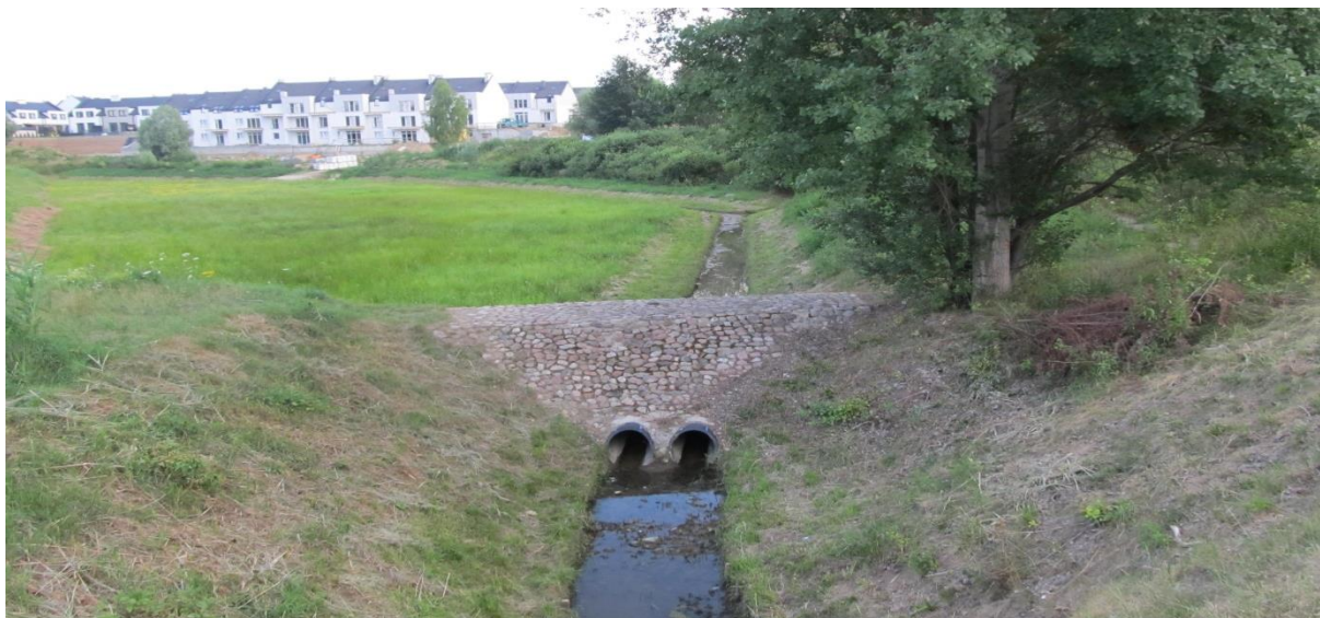
Zdjęcie 8. Rów melioracyjny w centralnej części obszaru
