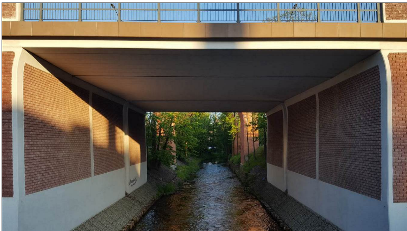
Fot. 7 Widok na most (w przebiegu ul. Artyleryjskiej) nad rzeką Łyną i umocnione koryto rzeki (fot. własna)
