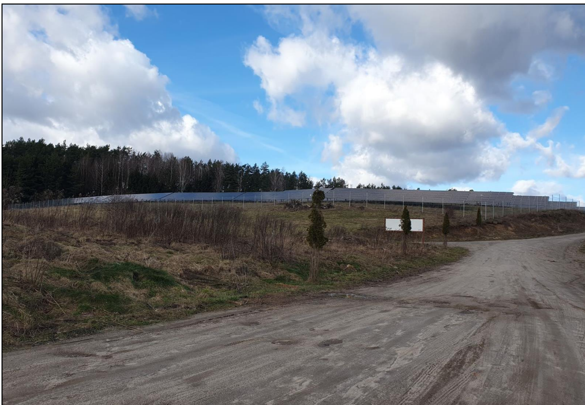
Fot. 5 Widok na panele fotowoltaiczne (fot. własna)
