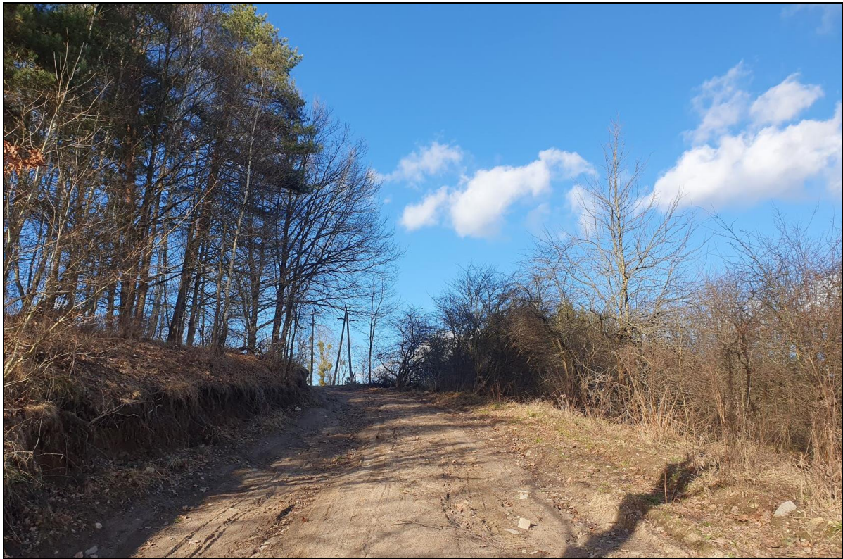
Fot. 8 Strome zbocza zlokalizowane wzdłuż ul. Żurawiej (fot. własna)
