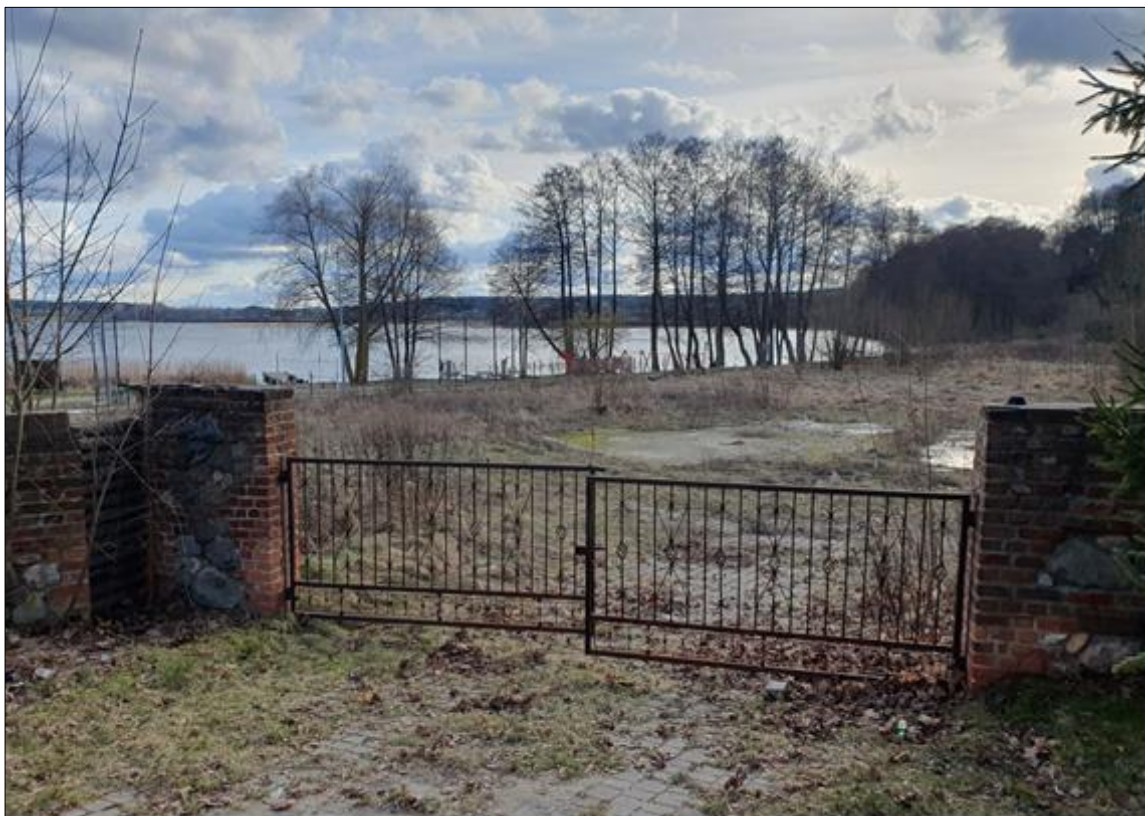
Fot. 1 Widok na fundamenty i pozostałości po rozbiórce budynku restauracji (teren 1UT-US-UG) (fot. własna)
