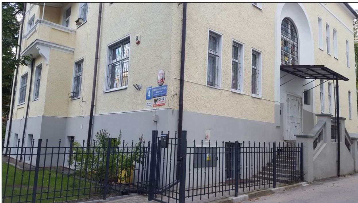
Fot. 1 Widok na część frontową budynku przedszkola (fot. własna)
