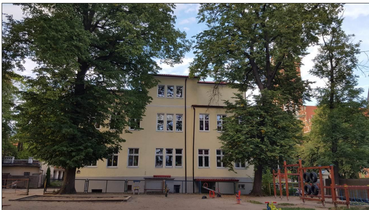
Fot. 2 Widok na tylną część budynku przedszkola i przyległy plac zabaw (fot. własna)
