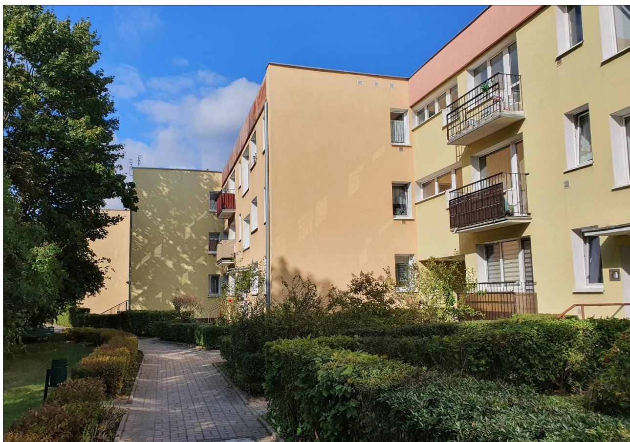
Fot. 5 Widok na zabudowę mieszkaniową, zlokalizowaną w sąsiedztwie wschodniej granicy terenu (fot. własna)
