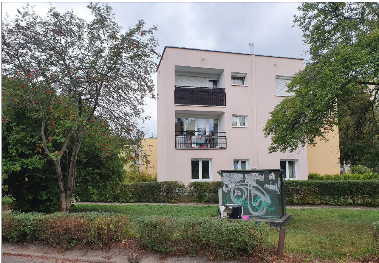
Fot. 6 Widok na teren zieleni (teren 7ZP) i stację transformatorową (teren 5E) (fot. własna)
