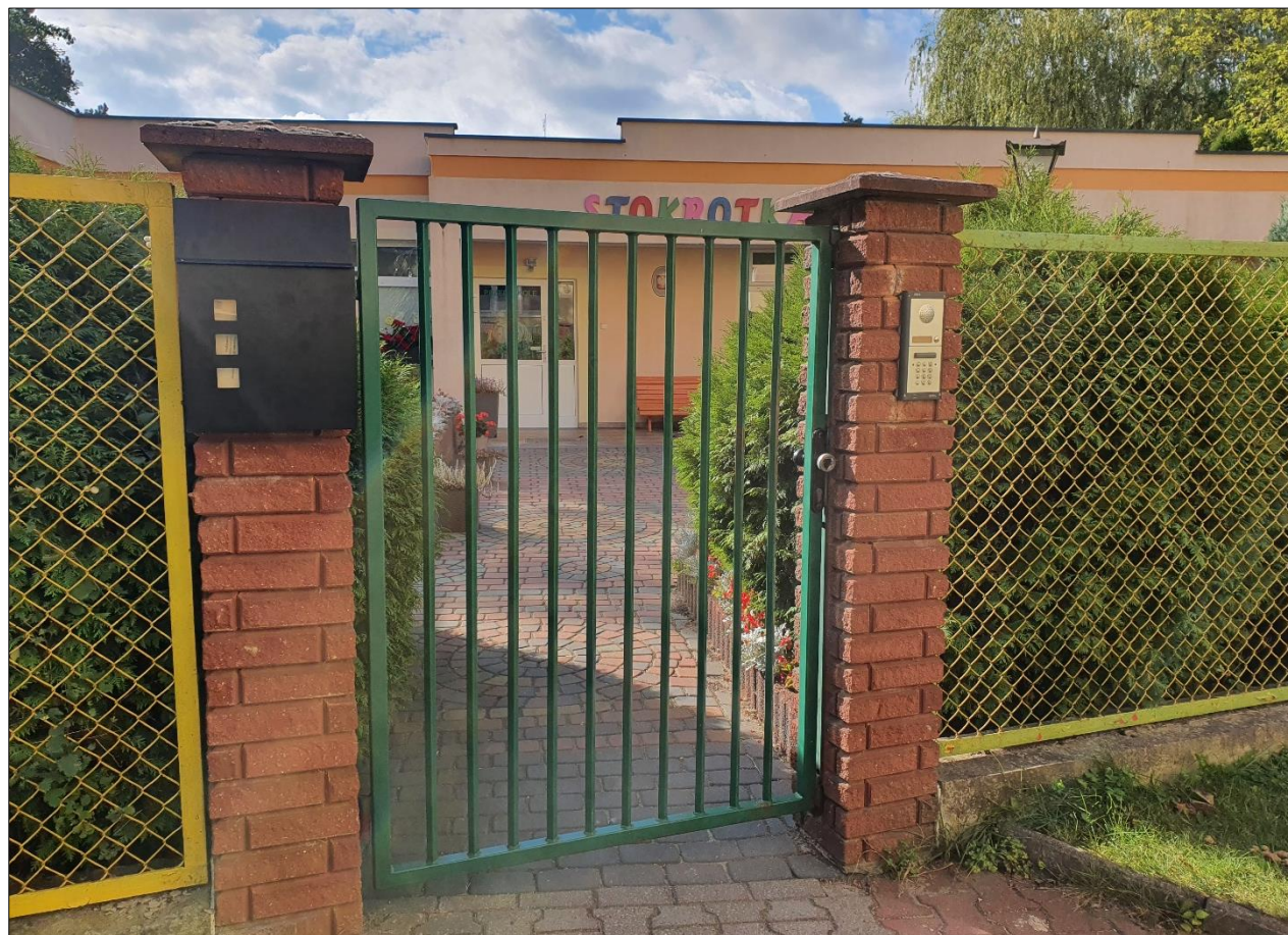
Fot. 3 Widok na wejście do budynku przedszkola od strony północno-wschodniej (od terenu 3KPP) (fot. własna)
