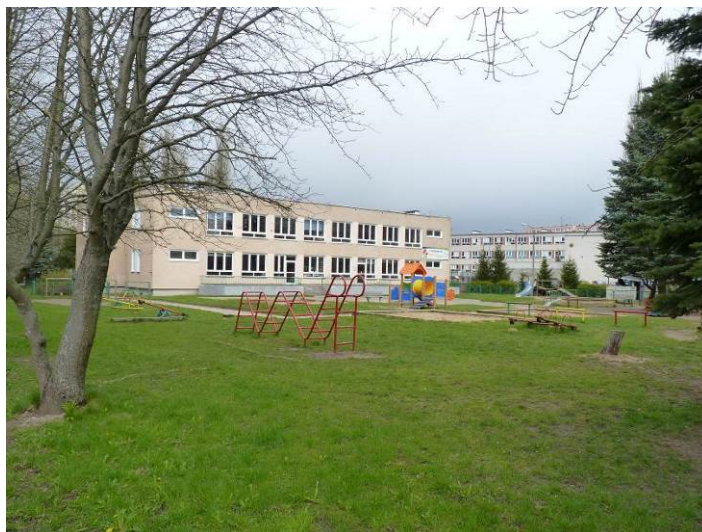
Zdjęcie. Budynek przedszkola i teren placu zabaw od strony południowej.
