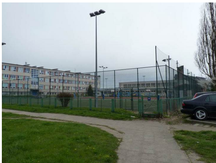
Zdjęcie. Teren Szkoły Podstawowej nr 22 zlokalizowany od strony północnej terenu objętego opracowaniem.
