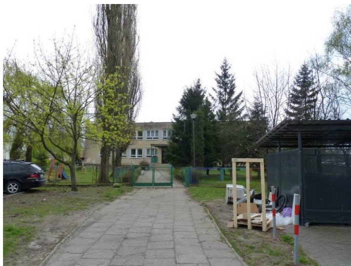
Zdjęcie. Widok na budynek przedszkola od strony północnej.
