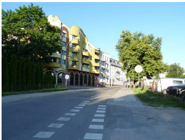
Zdjęcie. Zabudowa mieszkaniowo-usługowa sąsiadująca od strony północnej z terenem objętym opracowaniem.
