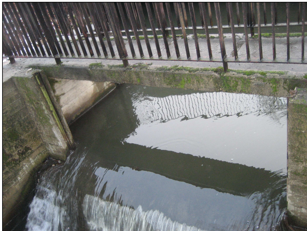
Fot. 7. Jaz na młynówce. Widoczne wneki na zastawkę
