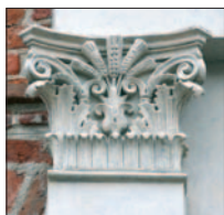
Fragmenty elewacji Starego Ratusza
