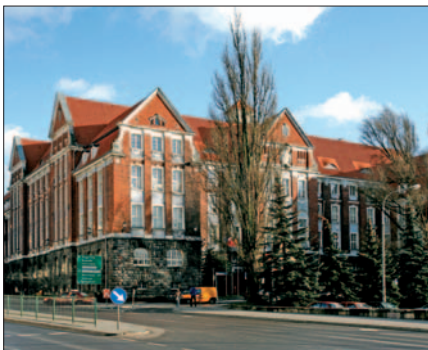
Budynek dawnej Rejencji, obecnie siedziba Samorządu Województwa Warmińsko-Mazurskiego i Wojewódzkiego Sądu Administracyjnego
